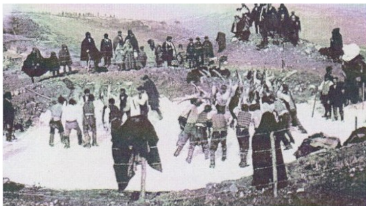
La foto rappresenta il momento della compressione della neve per la conservazione nella fossa
